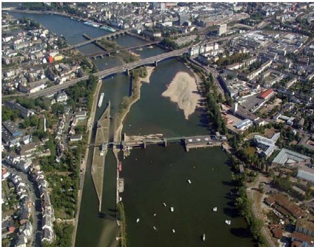
Staustufe Koblenz mit Wasserkraftwerk und zwei Schleusen
